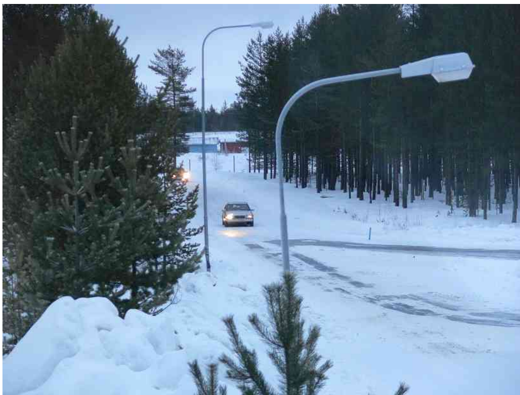
Фото 19 Полигон: скользкий участок дороги
