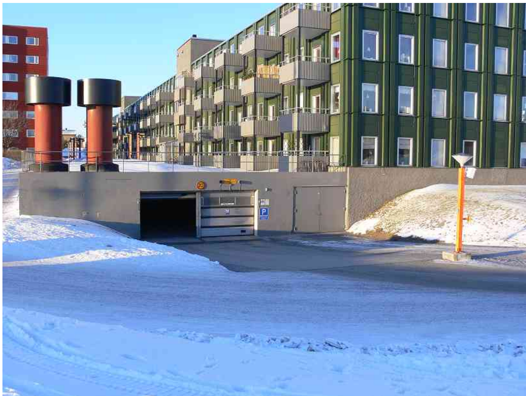
Фото 31 Лулео: подземный паркинг
