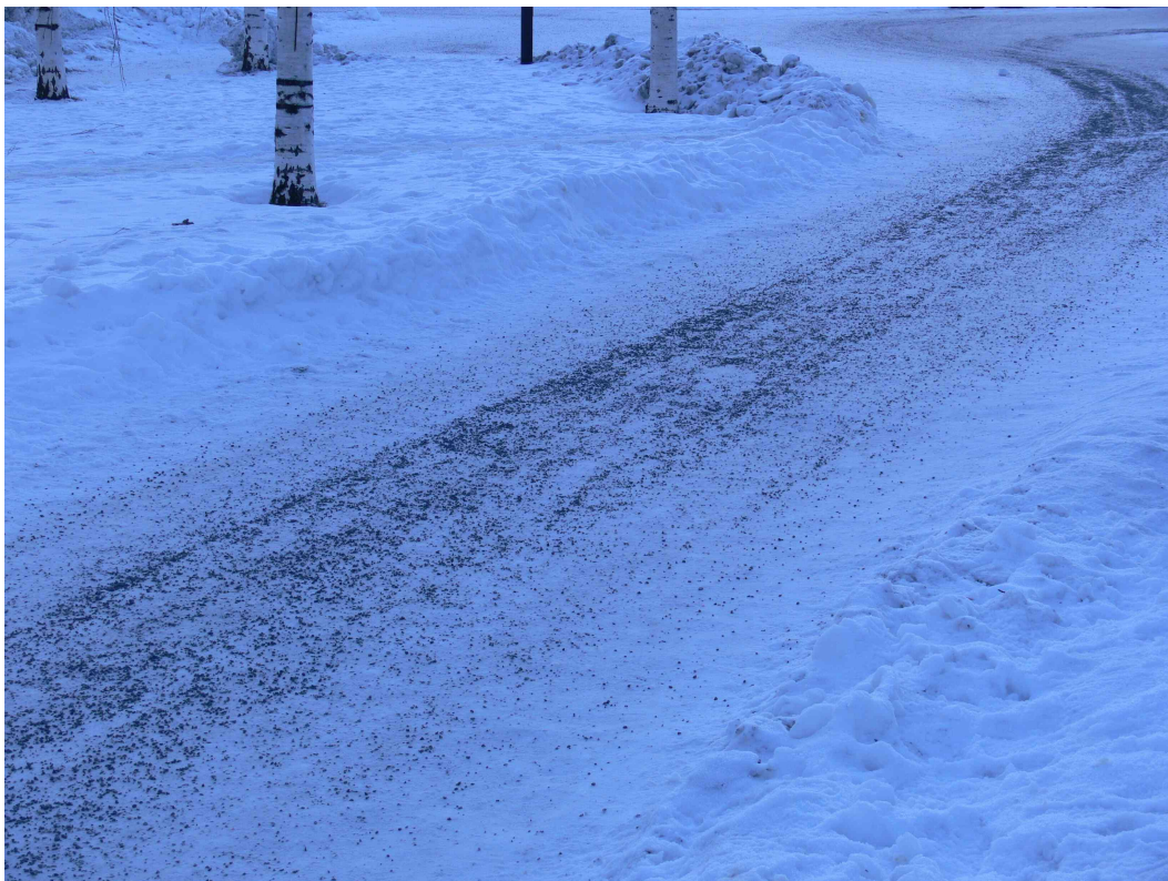
Фото 41 Лулео: использование мелкого щебня вместо песка (щебень можно использовать несколько раз)
