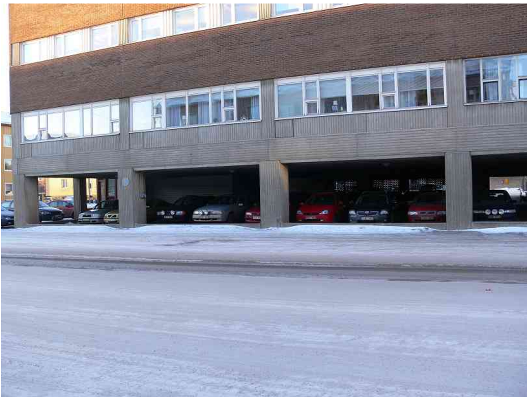
Фото 29 Лулео: парковка на первом этаже здания
