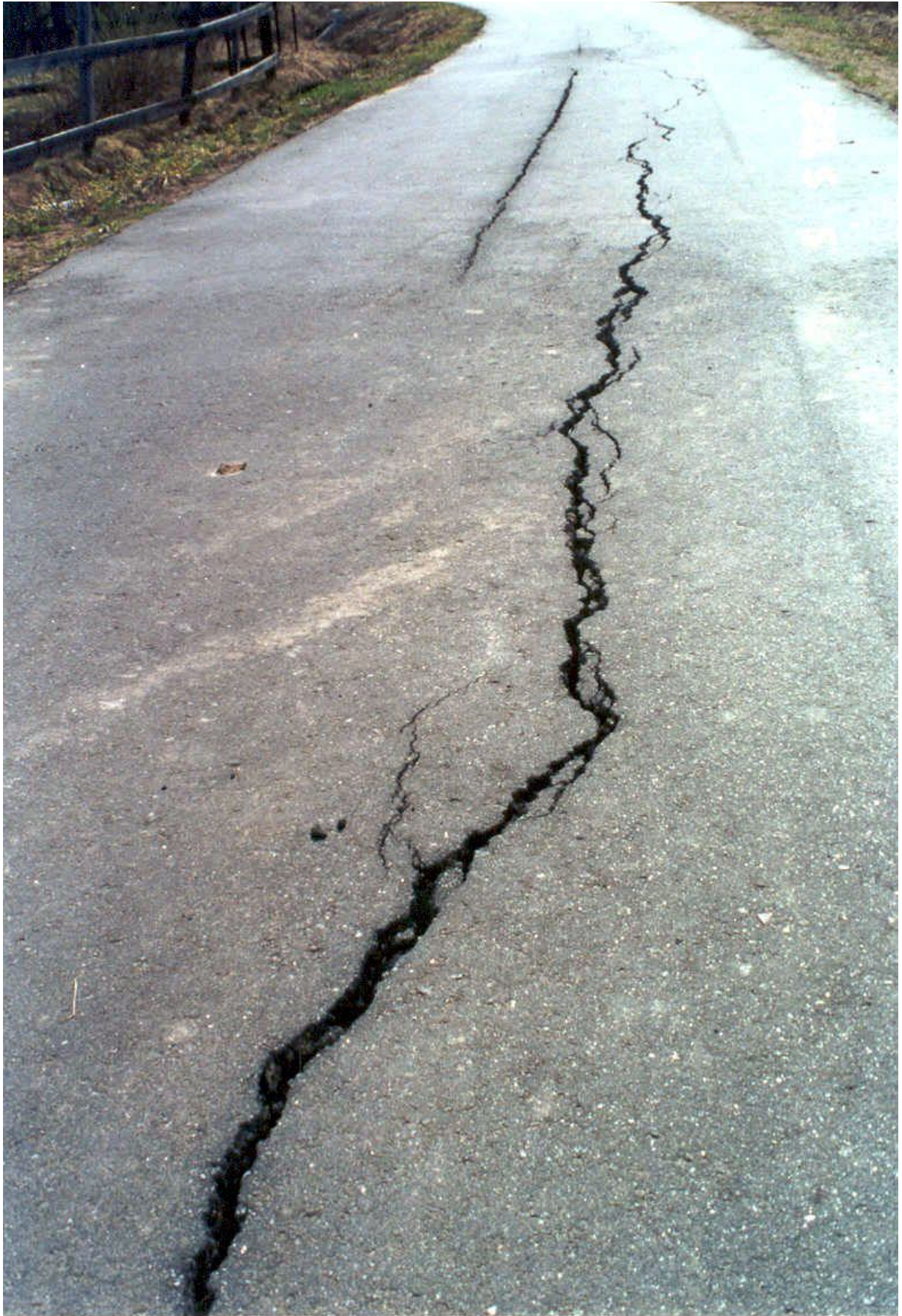
Рисунок 2 – Продольная Трещина
