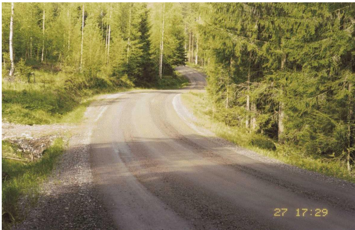
Рисунок 9: Гравийные дороги в северных странах ЕС – это те, которые не планируются к последующему переводу в капитальные дороги. Благодаря своевременному перепрофилированию и контролю пылеобразования, условия для движения транспорта хорошие. Такие дороги обычно узкие и, в условиях рельефной местности, извилистые.
