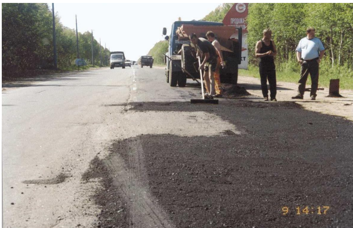
Рисунок 5: Производство ямочного ремонта на дороге вблизи Северодвинска.
