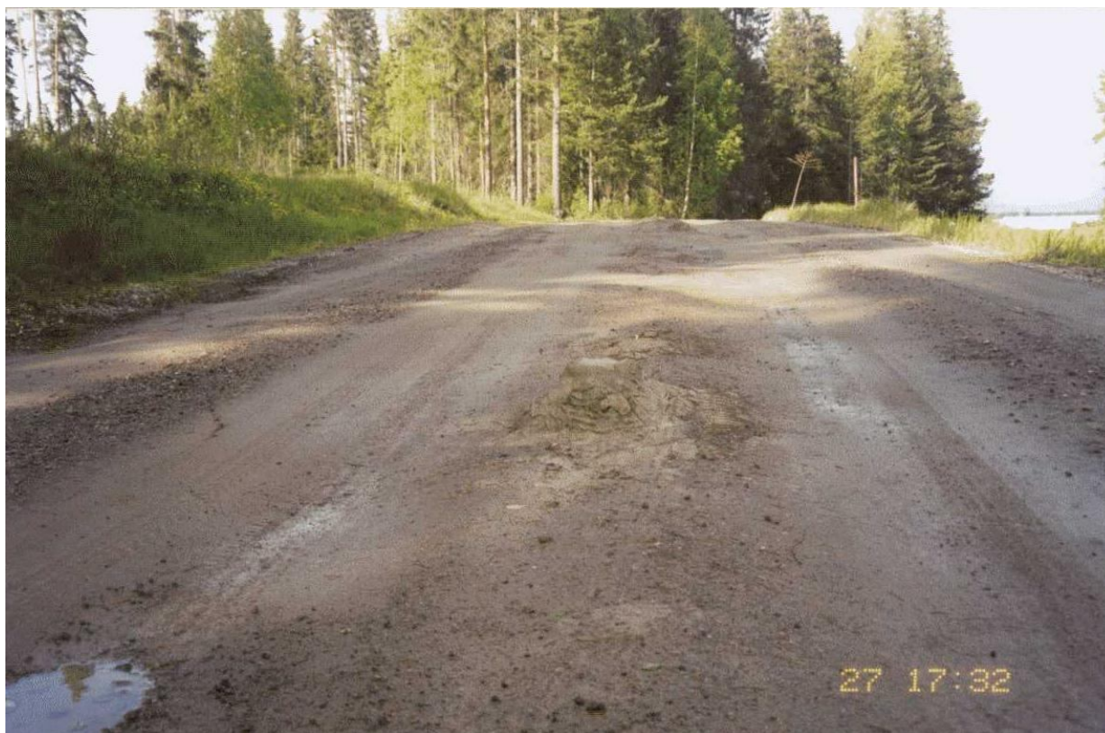
Рисунок 10: Весной несущая способность скандинавских гравийных дорог снижается. На этот период применимы ограничения для движения тяжелого транспорта.
