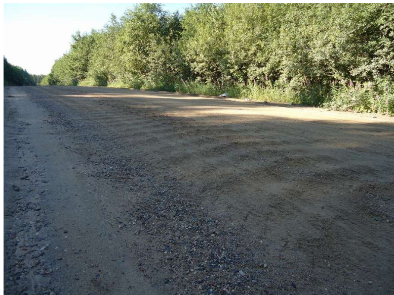
автодорога «Няндом-Шестиозерский», км 6+300. до производства работ
