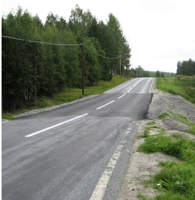
Неровности на участке с реконструируемой водопропускной трубой в Гаммельмо, участок а/д RDB section 133/000 км
