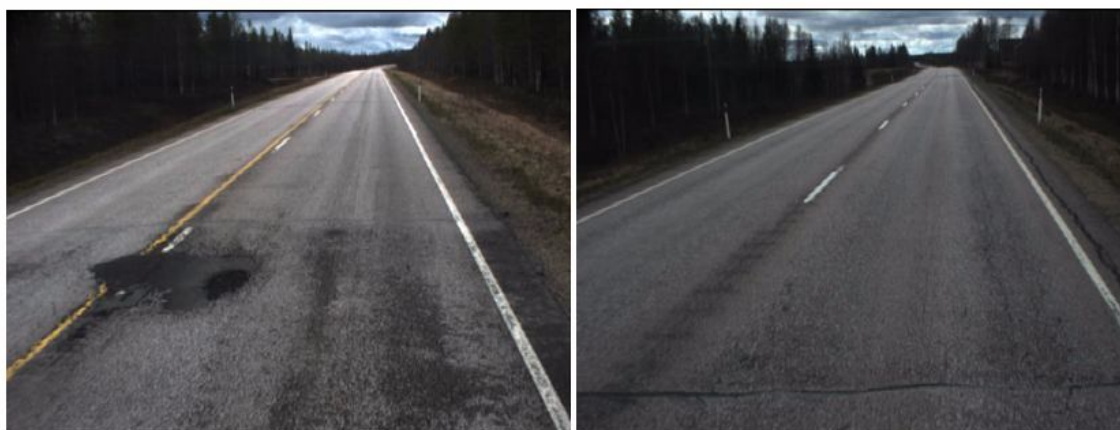
Рисунок 13. Участок 515, направление 2: Фото слева: 7000 м. Пятч (заделанная выбоина) посередине проезжей части. Фото справа: 4360 м. Поперечная трещина и разрушение левой кромки.
