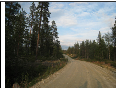
Фото 10 Пример контролируемой по ширине гравийной дороги с обеспечением быстрого отвода поверхностной воды в боковые канавы
