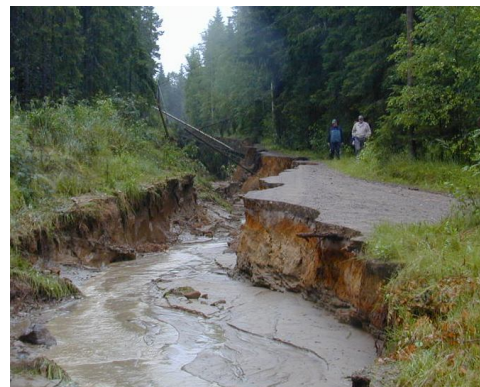
Рисунок 6 Сильные дожди могут привести к эрозии грунтов на дорогах с низкой интенсивностью движения в случае неудовлетворительного функционирования водоотвода
