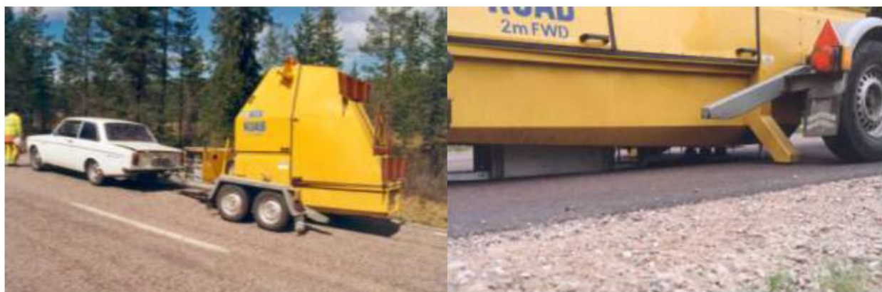
Рисунок 10 Оборудование – дефлектометр падающего груза, использованный на лесной дороге Timmerleden
