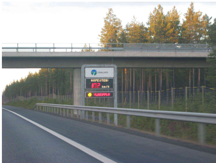
Фото 10 Финляндия: Знак переменных сообщений, предупреждающий водителя о превышении установленной скорости движения
