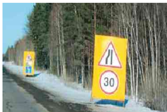
Фото 11 Примеры сигнализации в зонах дорожно-строительных работ
