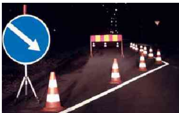
Фото 11 Примеры сигнализации в зонах дорожно-строительных работ
