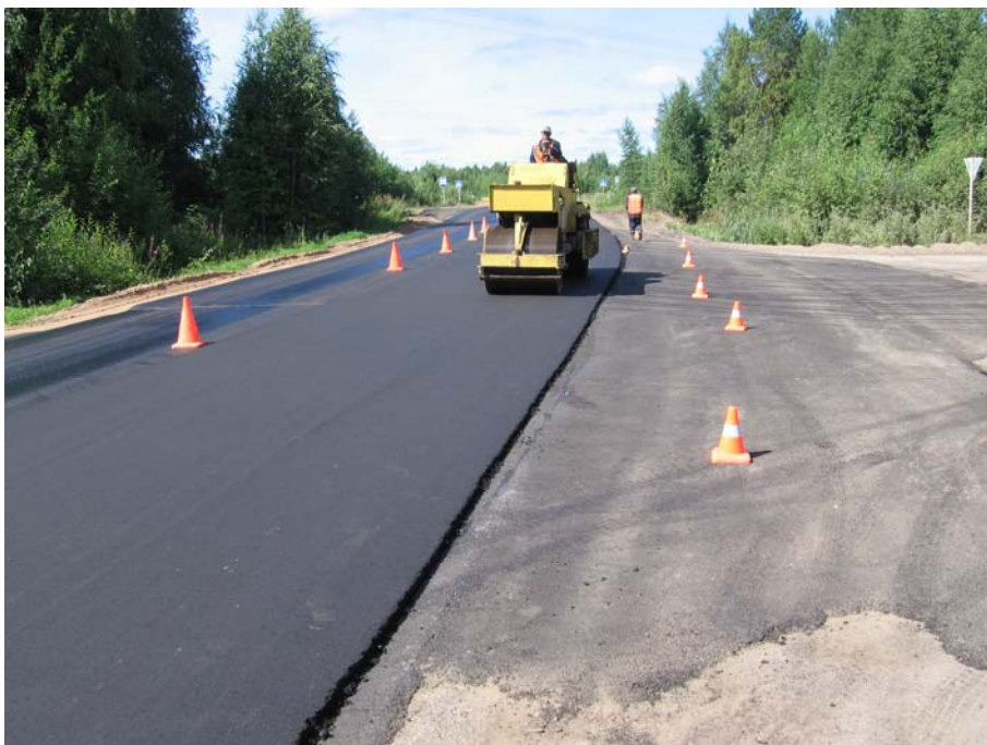
Рис.3. Уплотнение асфальтобетонной смеси приготовленной на основе БИТРЭК на а/д. Котлас - Коряжма - Виледь – И. Подомское км 55+800 – 56+400
