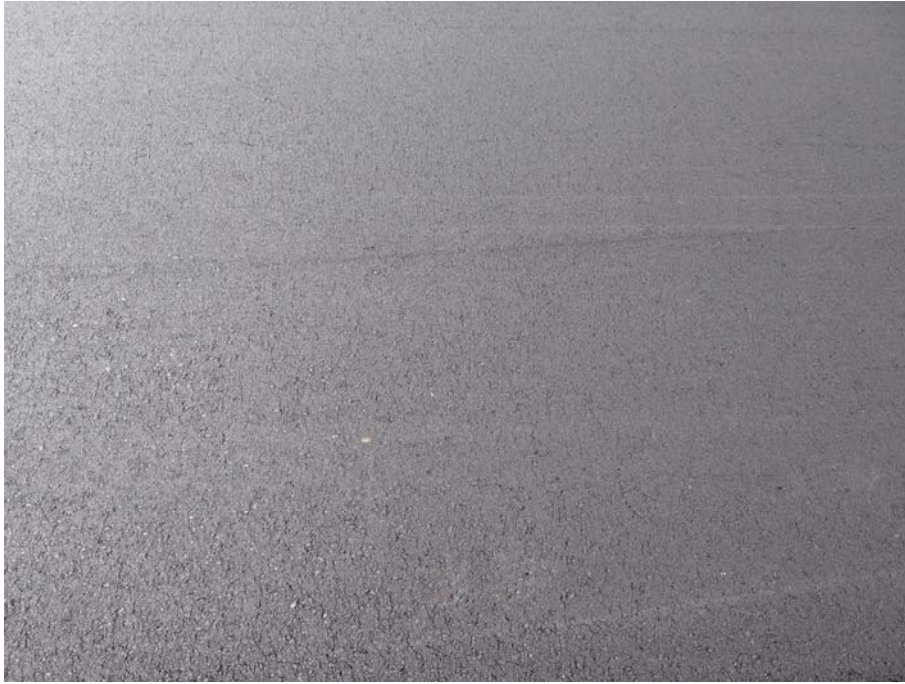
Рис.4. Вид асфальтобетонной смеси приготовленной на основе БИТРЭЖ на а/д. Котлас - Коряжма - Виледь – И. Подомское км 55+800 – 56+400
