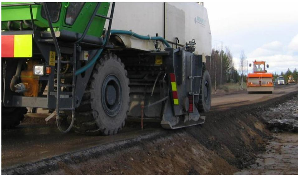
Остаточное содержание битумного вяжущего при стабилизации обычно составляет 3-4%, однако наилучших результатов можно достичь путем добавления лишь 1% битума в слой основания. Фактическое содержание битума зависит от содержания в материале мелких частиц. Грубую оценку содержания битумного вяжущего определяют по формуле:
