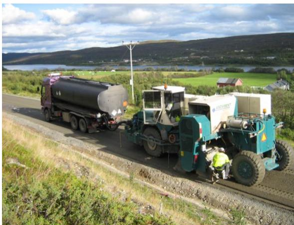
Опыт проектов ROAD EX в области стабилизации с использованием разных битумных вяжущих:
