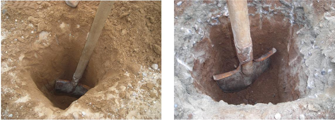
*Рисунок 3: Шурфы для отбора проб материалов дорожной одежды на пилотной дороге «Архангельск-Рикасиха-Онега»: км48 (слева) и км 58 (справа).*
