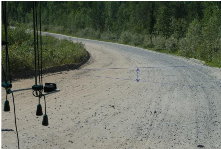
*Рисунок 10. Толщина дорожной одежды на внутренней кривой меньше, чем на внешней, что приводит к развитию деформаций.*
