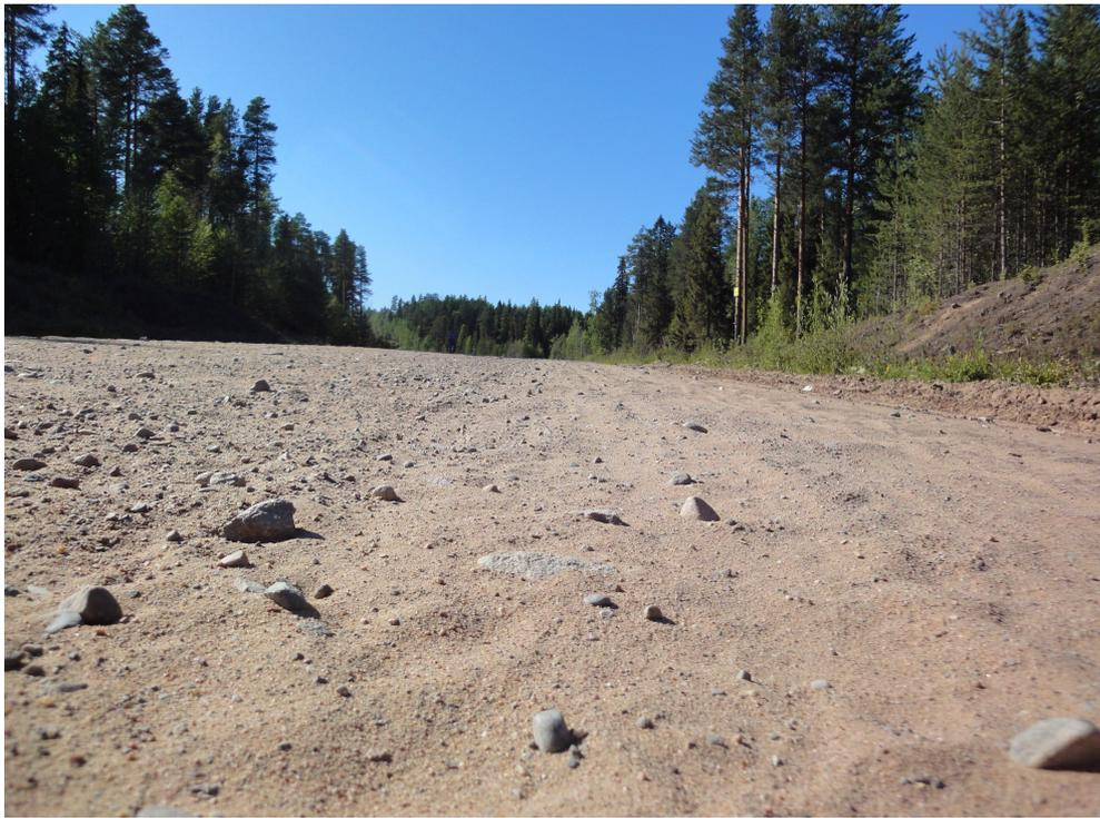
Рисунок 7. Состояние покрытия на пилотном участке, км 47. Покрытие неровное из-за наличия гребенки.
