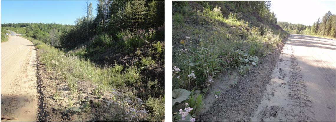
*Рисунок 9. Состояние обочин на пилотном участке, км 47. Превышение уровня обочин на проезжей части и наличие растительности создают проблемы для водоотвода. Справа боковая канава отсутствует.*
