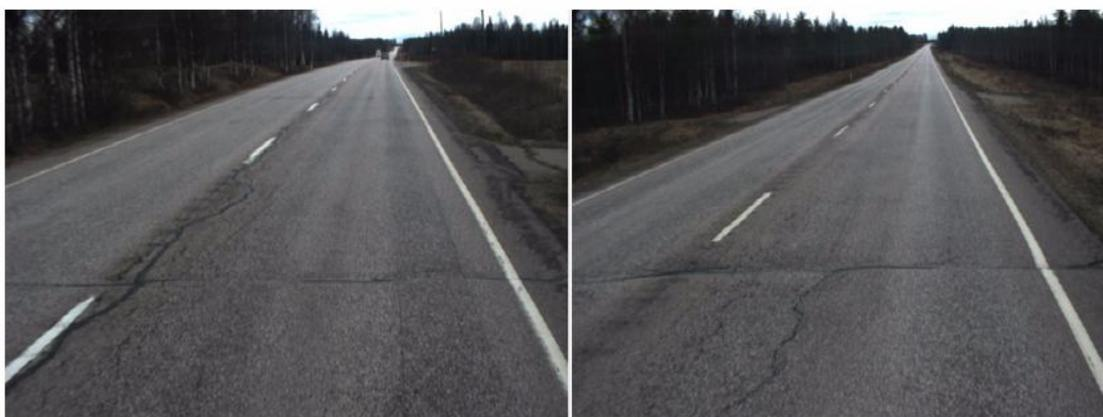
Рисунок 12. Участок 515, направление 1: фото слева: 4000 м. Продольные, поперечные трещины и сетка крокодиловых трещин. Фото справа: 4460 м. Продольные, поперечные трещины и сетка крокодиловых трещин.
