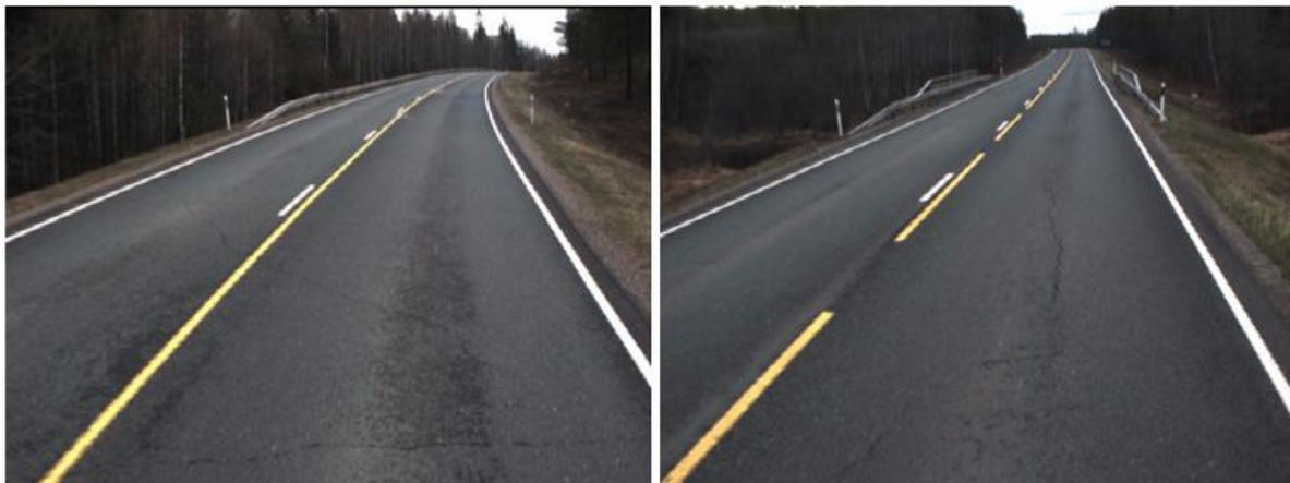
*Рисунок 10. Участок 505, направление 1: Фото слева: 350 м. Поперечные трещины, вызванные дифференциальным морозным пучением, на участке косогора. Фото справа: 3200 м. Вызванная воздействием мороза продольная трещина перед мостом.*
