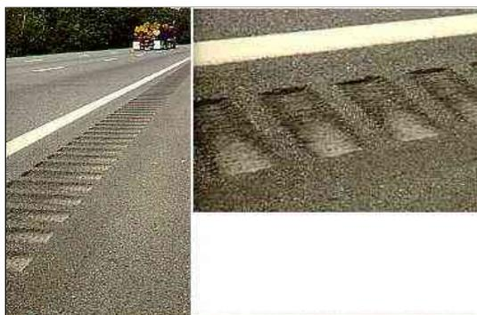
*Мероприятия, предлагаемые для снижения аварийности на участке концентрации ДТП, в составе низкзатратного пакета – шумовые полосы параллельно кромке проезжей части*
