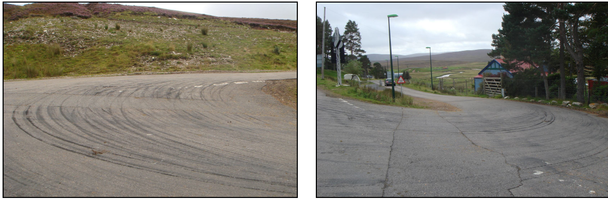
Рисунок 4.6 Фотографии следов торможения на участке примыкания дорог B871/A897 в Кинбрейсе
