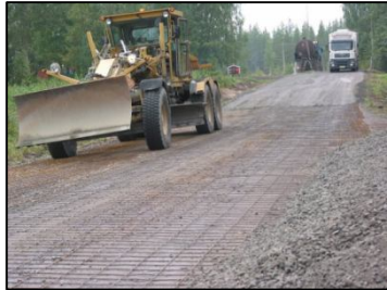
Усиление конструкции дороги
