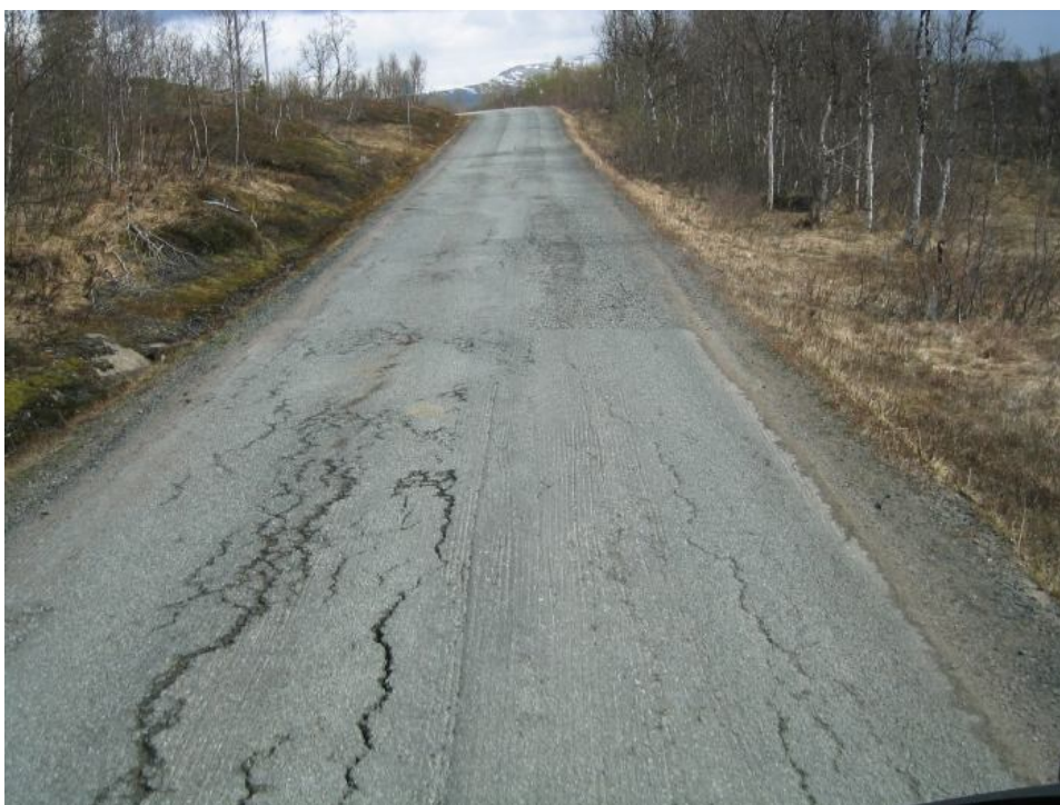
Рисунок 2. Дорога с низкой интенсивностью движения на острове Сенья в Северной Норвегии, подверженная возникновению остаточных деформаций по причине неадекватного водоотвода и тонкослойности конструкции дорожной одежды.
