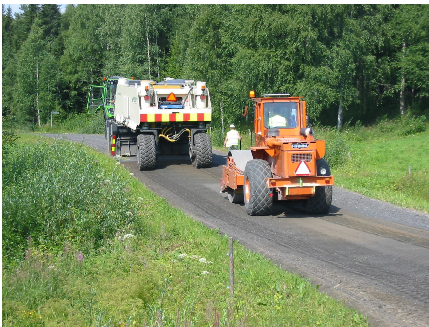
Рисунок 3. Повышение несущей способности основания дорожной одежды на дороге с низкой интенсивностью движения посредством стабилизации
