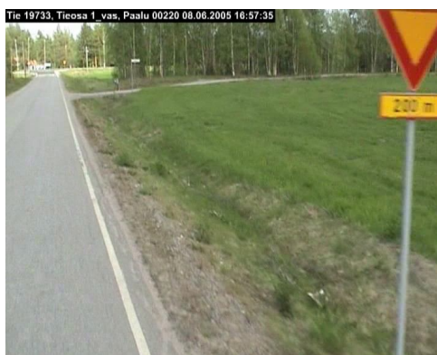
Рисунок 2.1 Пример правильного позиционирования цифровой видеокамеры: направление на боковую канаву и обочину
