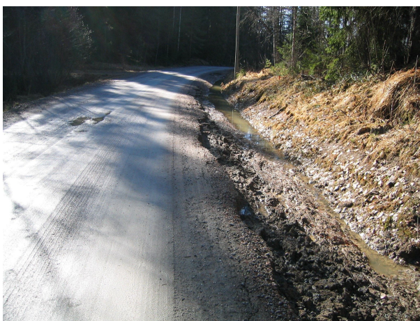
Рисунок 3.5 Обрушение обочины дороги, проложенной по заиленным участкам. Фото сделано весной после первой очистки канав.
