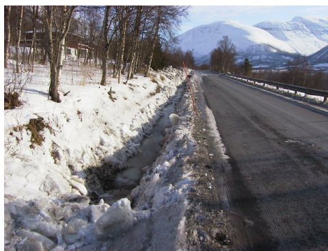
Рисунок 3.3 Очистка боковых канав от снега и льда
