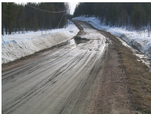
Рисунок 3.8 Проблемный водоотвод на дорогах, проходящих в низине, А/д 19778, Кемиярви, Финляндия
