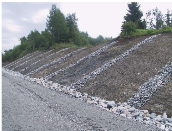
Рисунок 3.1 Пример укрепления откоса в дорожной выемке
