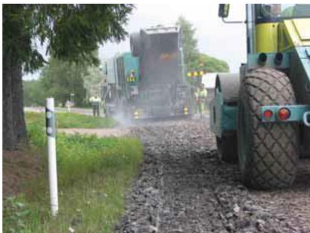
**Рисунок 5.4. Слой существующего покрытия измельчается и перемешивается с материалом основания (T.Ruohomäki)**
