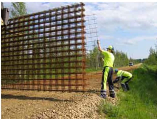
**Рисунок 5.1. Установка стальных сеток усиления (К. Niva)**
