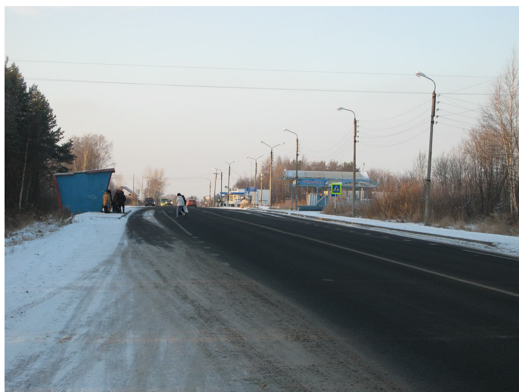
фото 4,5 ОБУСТРОЙСТВА ПЕШЕХОДНЫХ ПЕРЕХОДОВ НЕ СДЕЛАНО, кроме использования знаков, обозначающих переход на люминесцентной подложке
