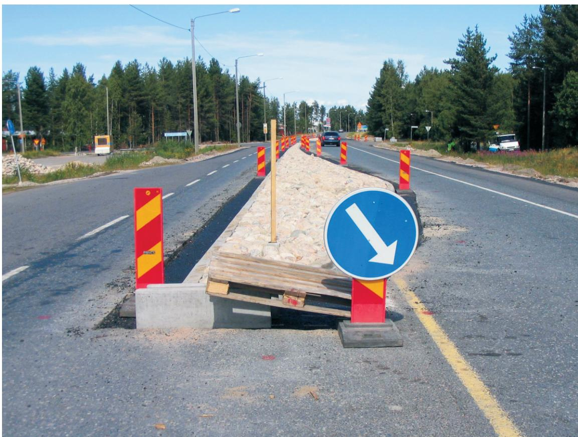
**Фото 1. Строительство островка безопасности на аварийном примыкании с левым поворотом**
