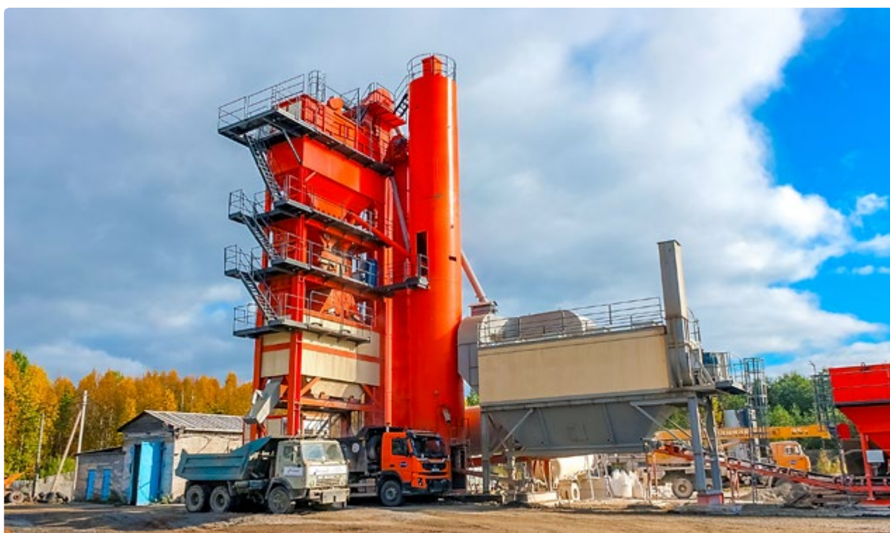
Новый асфальтобетонный завод в Карпогорах
