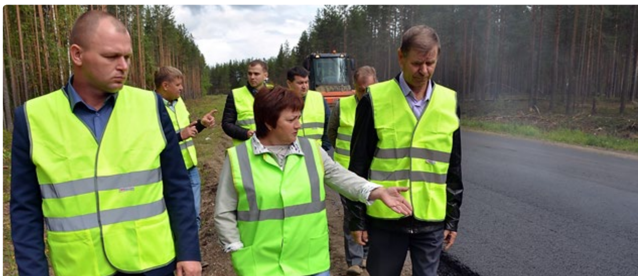
Общественники inspectируют объект ремонта
