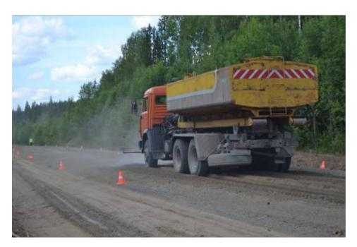
Распределение стабилизатора велось с использованием автогудонатора. Так как техника не оборудована современными средствами контроля дозирования в зависимости от скорости, вопрос был решен следующим образом. Требуемое по расчету количество раствора стабилизатора в воде (в нашем случае 40 л стабилизатора и 20 тонн воды) было загружено в автогудронатор, и с небольшой скоростью подачи было сделано большое число проходов по всему участку (не менее 20), пока весь раствор не был равномерно распределен.
